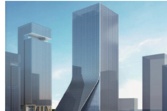
深圳前海卓越金融中心项目 SHENZHEN QIANHAI EXCELLENT FINANCIAL CENTER PROJECT
